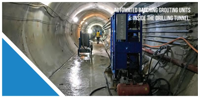
AUTOMATED BATCHING GROUTING UNITS INSIDE THE DRILLING TUNNEL.
