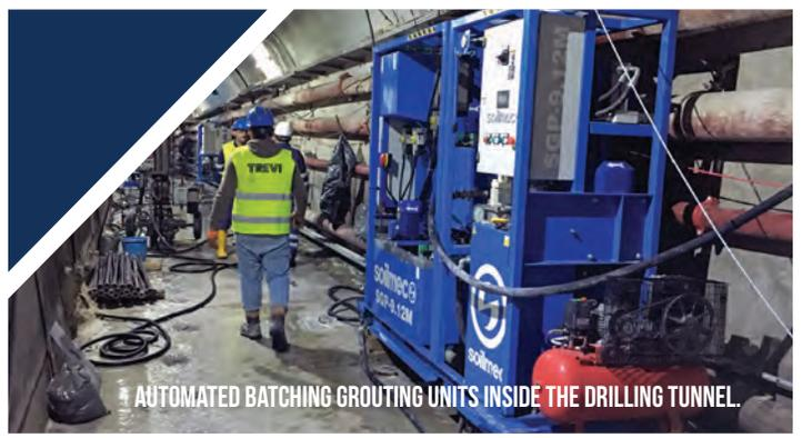
AUTOMATED BATCHING GROUTING UNITS INSIDE THE DRILLING TUNNEL.
