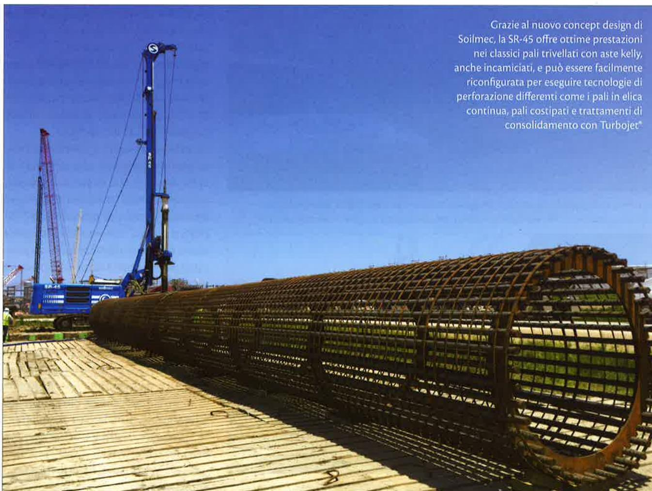
Grazie al nuovo concept design di Soilmec, la SR-45 offre ottime prestazioni nei classici pali trivellati con aste kelly, anche incamicciati, e può essere facilmente riconfigurata per eseguire tecnologie di perforazione differenti come i pali in elica continua, pali costipati e trattamenti di consolidamento con Turbojet®
