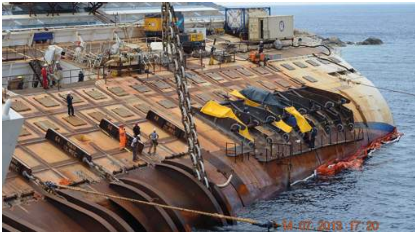
Preparativi per il "Parbuckling"; stesura delle catene di ritenuta
