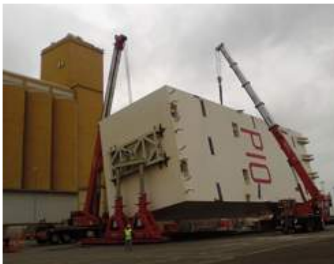
Cassoni progettati dalla Spline pronti a lasciare il cantiere di Livorno destinati al Giglio dove saranno successivamente installati sulla Costa Concordia
