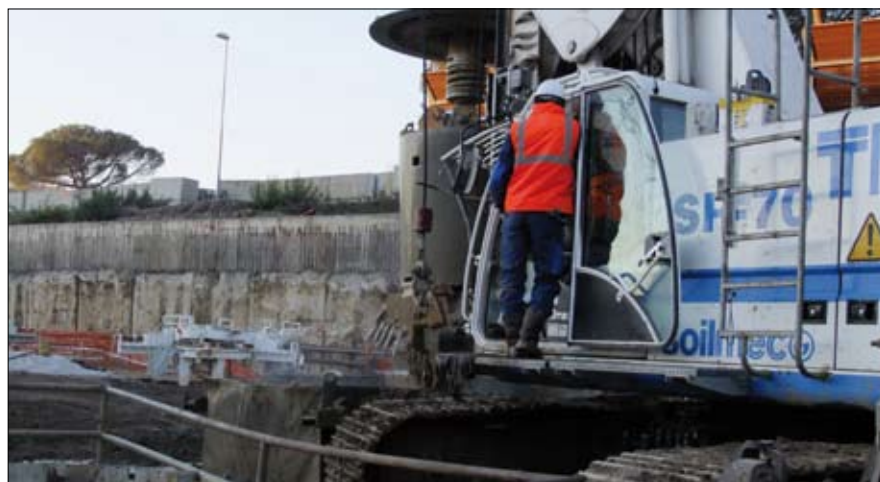
Fase di scavo
