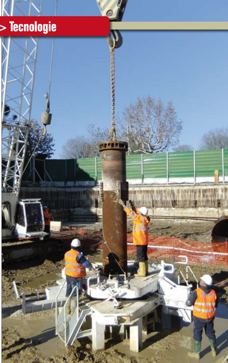
Posizionamento della colonna pilastro metallica
