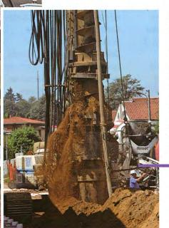
**Nella versione CAP/CSP** la SR-100 è equipaggiata, oltre alla rotary superiore che aziona l'elica, con una seconda rotary indipendente che trasmette al casing una coppia massima nominale di 448 kNm. L'utilizzo di due rotary tra di loro completamente indipendenti permette all'operatore di far avanzare ed estrarre elica e casing autonomamente, sfruttando appieno la potenza della macchina.
