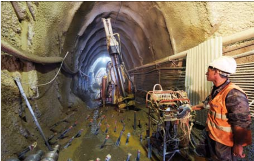
Consolidamento dei terreni tramite jet-grouting in corrispondenza della galleria di Arcisate
