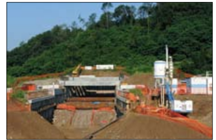
L'imbocco della nuova galleria di Gaggiolo: il tunnel sarà realizzato con tecnica cut & cover
