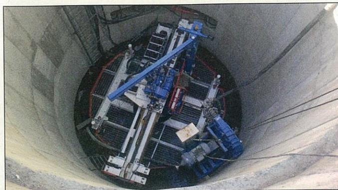
Figura 3 - L'esecuzione di perforazioni dal pozzo di medio diametro con una perforatrice PSM
