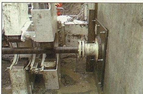
Figura 9 - Il preventer fissato al muro della vasca di raccolta
