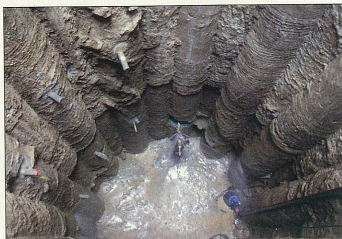
Figura 5 - Un dettaglio dei pali CSP e dei dreni
