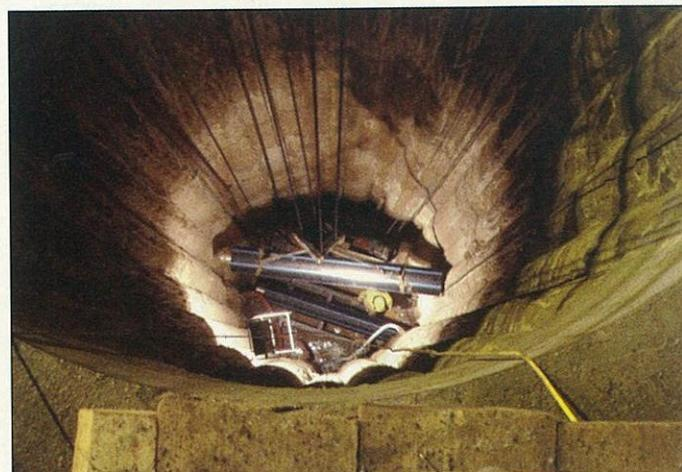
Figura 12 - Il calo delle barre di tubo nei pozzi e assemblaggio della condotta in fase di tiro
