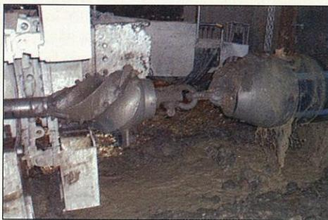
Figura 8 - L'uscita dell'alesatore e della testa della condotta dalla parete della vasca di accumulo
