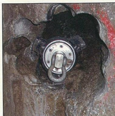
Figura 11 - Il carotaggio dei pali e l'inserimento dell'alesatore
