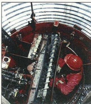
Figura 2 - La capsula per le microperforazioni da palo-pozzo D 1.200 mm
