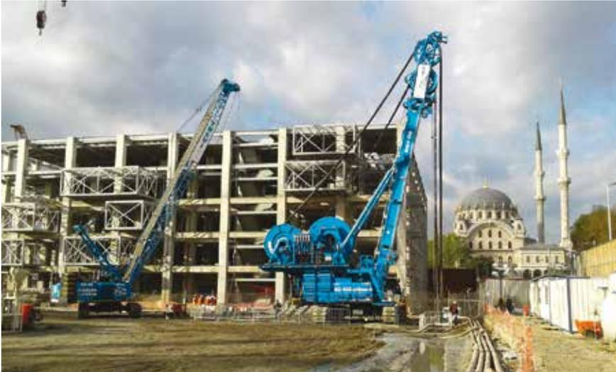
LA COMPLESSITÀ DEL PROGETTO IN CUI È STATA IMPIEGATA LA IDROFRESA SOILMEC HA PREVISTO LA REALIZZAZIONE DI STRUTTURE SOTTERRANEE SIA IN AREE APERTE CHE AL DI SOTTO DEGLI EDIFICI STORICI ESISTENTI E HA RICHIESTO L'IMPIEGO DI UNA VASTA GAMMA DI TECNOLOGIE PER LA REALIZZAZIONE DELLE OPERE DI SOSTEGNO DEGLI SCAVI, DI FONDAZIONE E DI CONSOLIDAMENTO DEL TERRENO IN UN CONTESTO A ELEVATA SISMICITÀ
